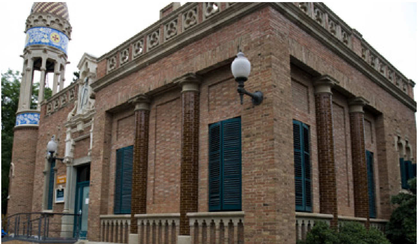
Foto: Edifici de Direcció Institut de Recerca de Sant Pau
